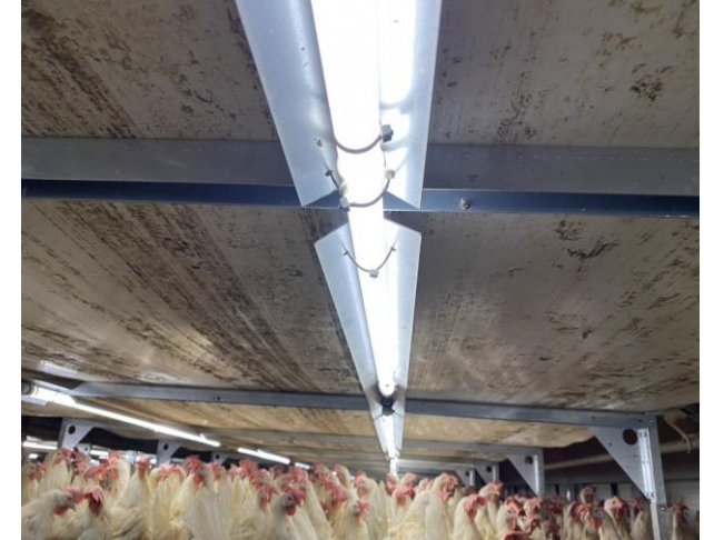
Metaal boven ledtubes
